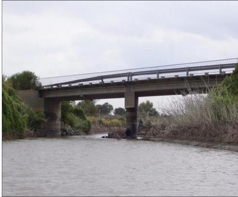
Sección de Aforos del Río Salado en Puente Malbrán- Bandera (foto Google)
