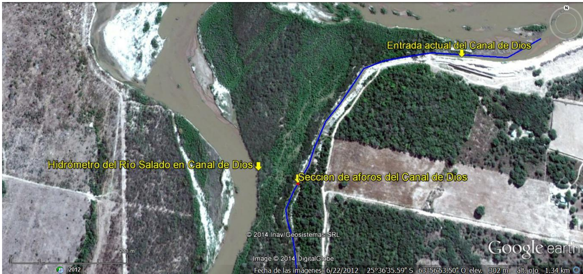
Ubicación de la sección de aforos sobre el Canal de Dios y el Hidrómetro sobre el Río Salado. 25°36'38.72\"/>
