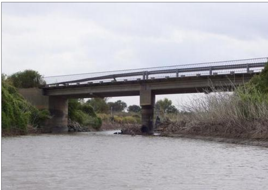
Sección de Aforos del Río salado en Puente Malbrán- Bandera (foto Google)
