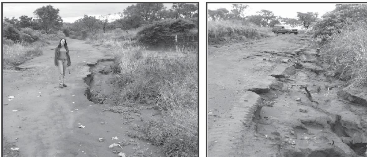
**Figura 50.** Cunetas y carpetas de rodamiento erosionadas.
