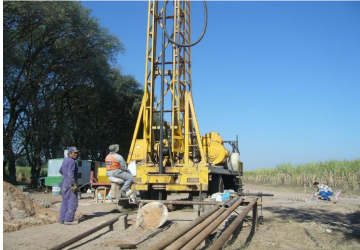
Inicio de la perforación
