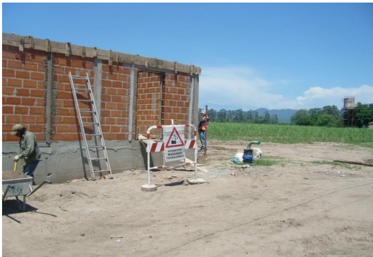
Depósito de bombeo y casilla aledaño al pozo
