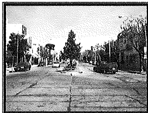
Foto 4.- Boulevard calle S. del Carril
