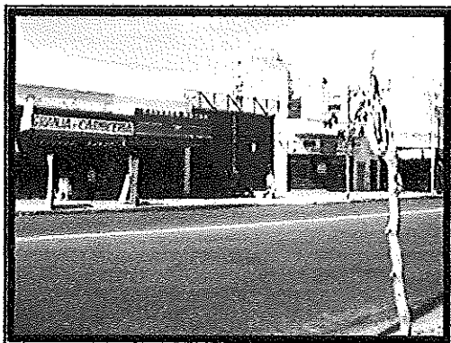
Foto 7.- Av. Beiró, entre Molire y Virgilio, único acceso vehicular, donde se tiene proyectado rotura de vereda
