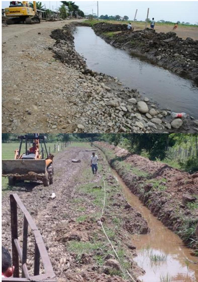
*Foto 18: Distintos tipos de zanjas de drenaje.*
