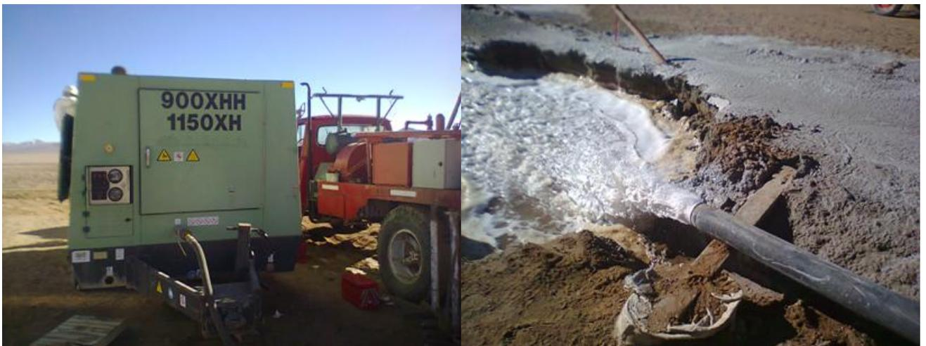
Foto 46: Desarrollo de pozo con aire comprimido. Izquierda, compresor con manguera de inyección de aire al pozo. Derecha, producción de agua. Salar del Hombre Muerto (provincia de Catamarca).
