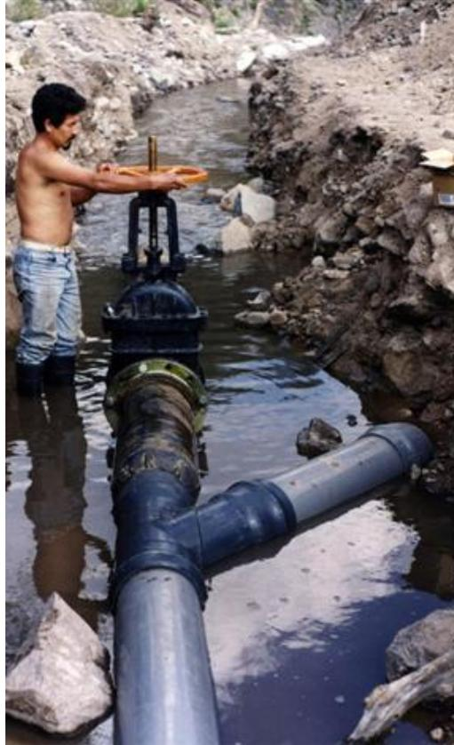
*Foto 23: Dren conectado a cañería de limpieza y purga (derecha) y a llave exclusiva para regulación del caudal de producción (Candonga, Córdoba).*
