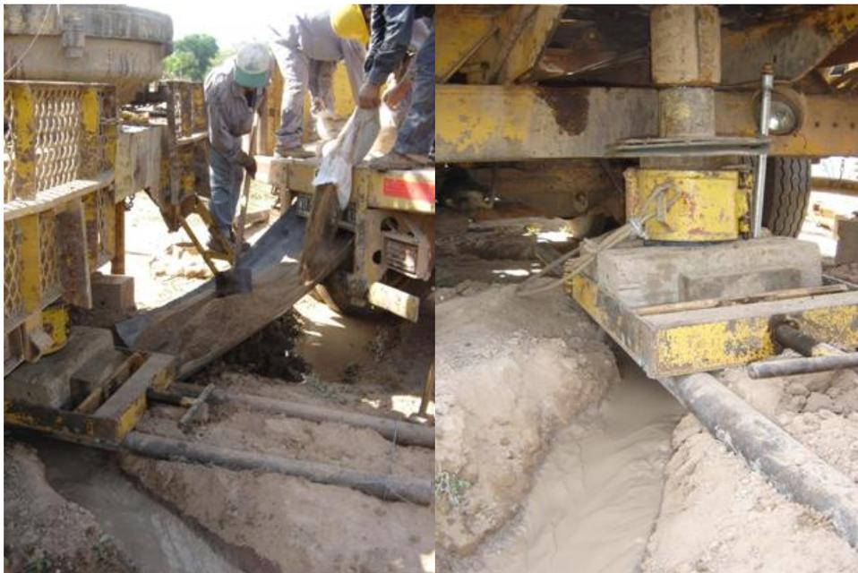
*Foto 44: Izquierda, colocación de material prefiltrante en el espacio anular entre la pared externa de la columna de entubación y las paredes del pozo. Derecha, platina para circulación forzada de lodo en el espacio anular.*
