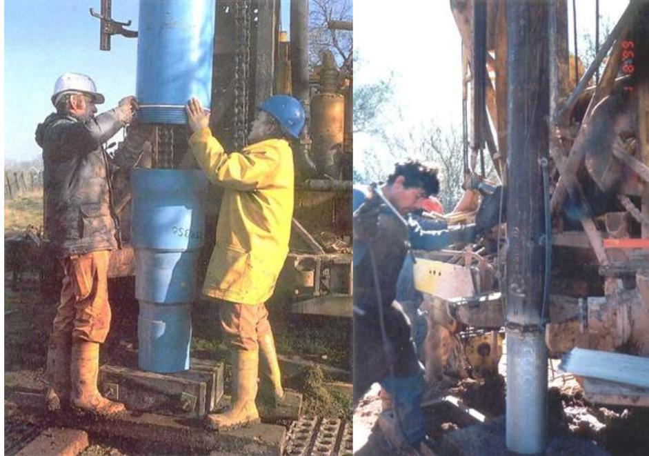
*Foto 41: A la izquierda se observa una entubación con cañería de PVC, mediante roscas. A la derecha, columna de entubación (filtros y caño ciegos) en acero con conexión entre ambos tramos con soldadura eléctrica.*
