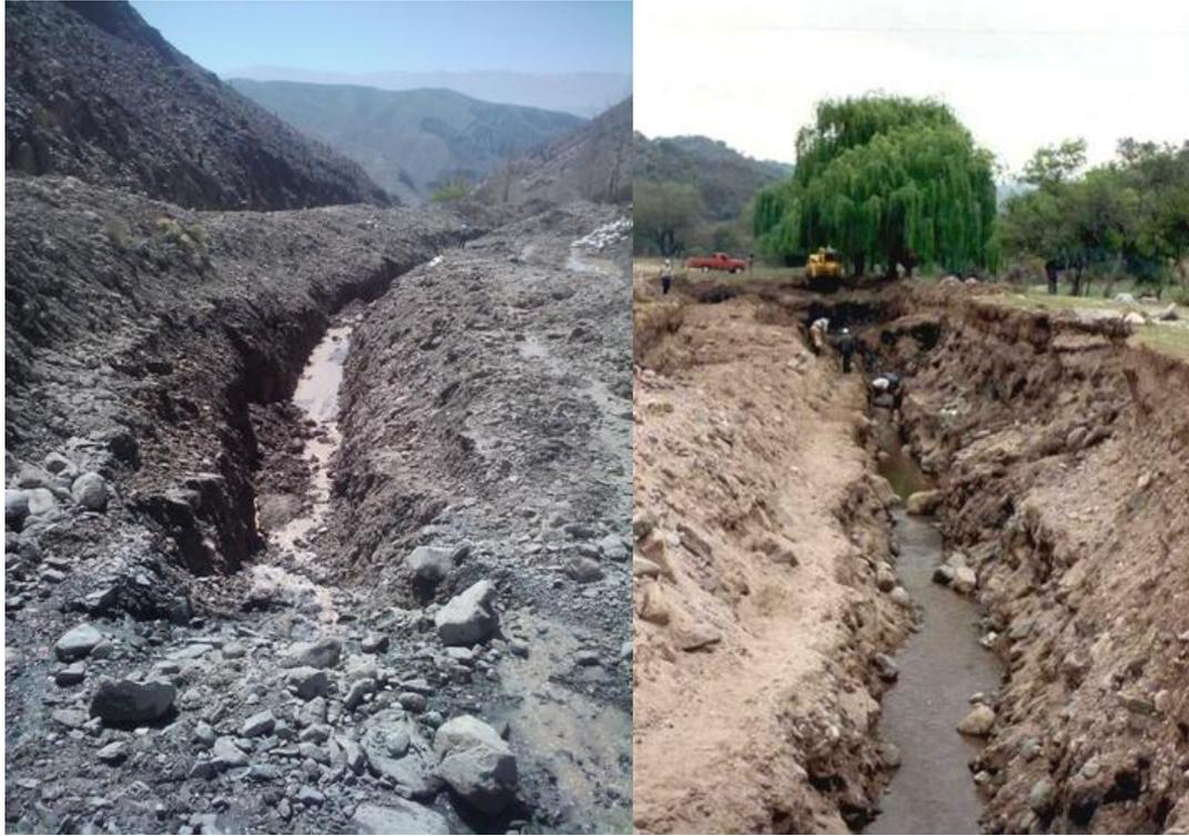
*Foto 21: Secuencia de una excavación para la construcción de un dren. A la izquierda excavación con máquina retroexcavadora en Alfarcito (Salta); a la derecha, excavación manual en el valle de Candonga (Córdoba).*
