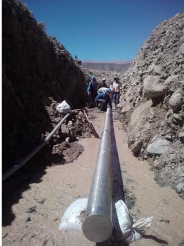
*Foto 22: Colocación de filtros y prefiltro en el dren de El Alfarcito (Salta).*
