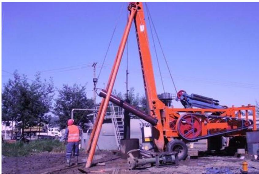
Foto 29. Equipo de percusión y herramientas (en primer plano se observa la cuchara).
