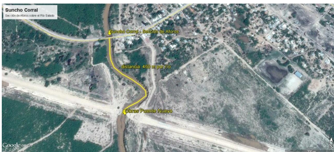
Sección de aforos del Río Salado en Suncho Corral y construcción nuevo puente.
