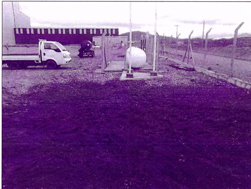
Figura 2. Área de la perforación cegada
