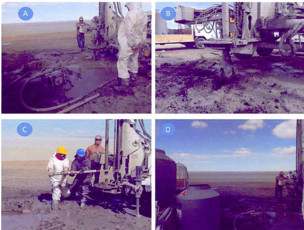
Figura 2: Compilación fotográfica de algunas de las tareas realizadas. A) Circuito de perforación con lodo bentonítico; B) Trépano de perforación, tricono 8"; C) Maniobra: adhesión de barra de perforación; D) Tanque de agua 1000 l. para lodo
