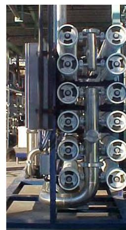
Figura 4. Instalación de ósmosis inversa.
