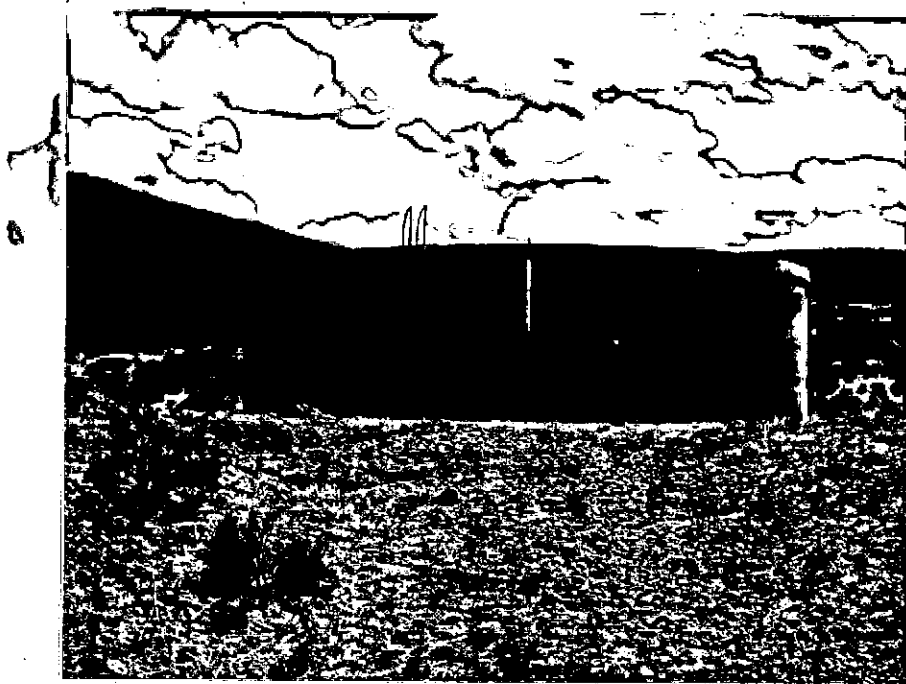
Caleta Olivia: Sistema Cañadón Quintar. Cisterna de almacenamiento n° 4, de 500 m 3 de capacidad, a la que acceden los volúmenes por los pozos n° 13, 17, 22 y 30.
