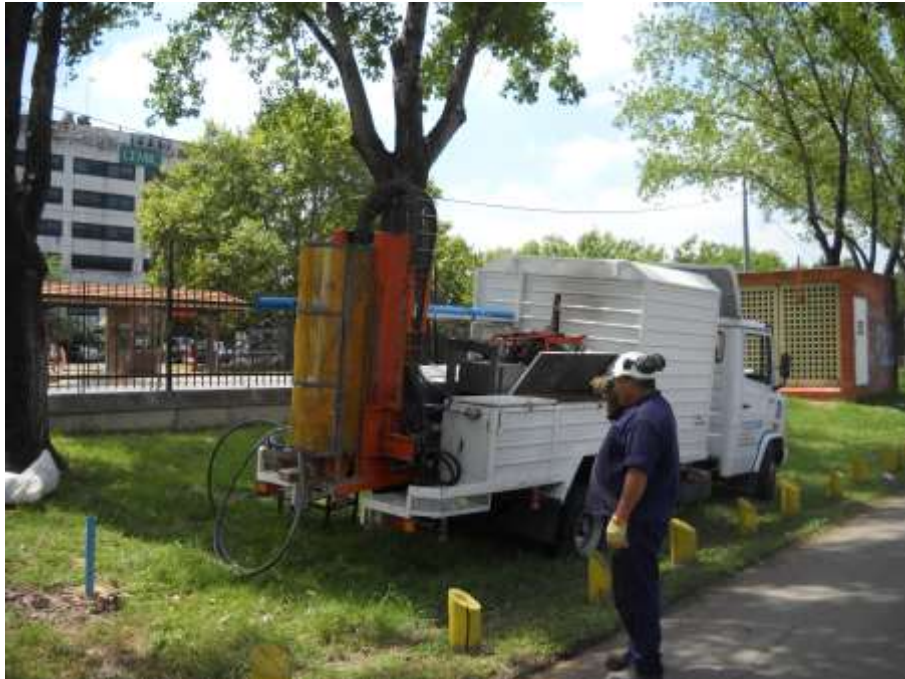
Fotografía 1. Vista trabajos de perforación (F1).
