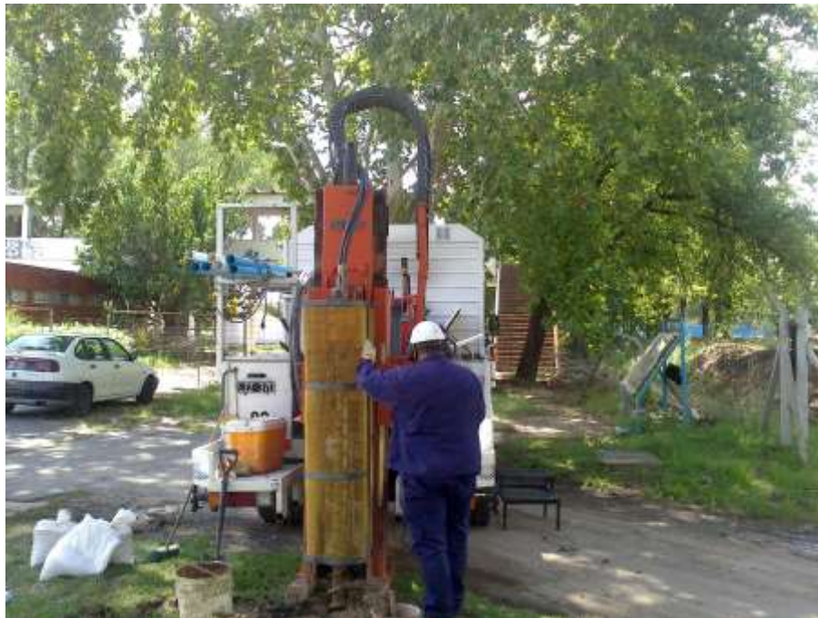
Fotografía 3. Vista trabajos de perforación (F3).
