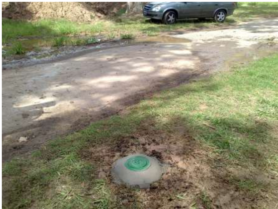
Fotografía 4. Vista terminación boca de pozo (F3).
